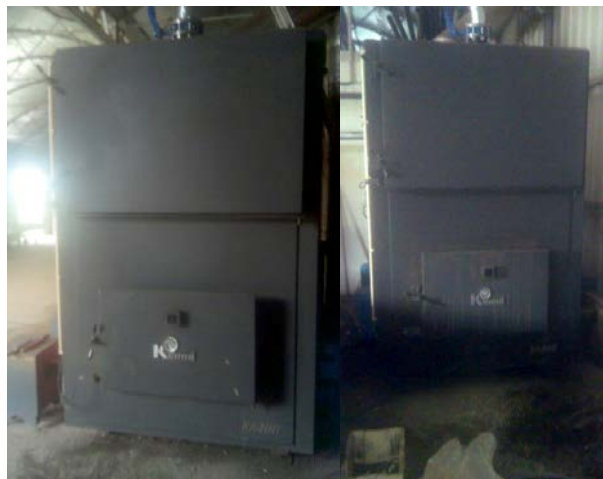
Figura 2. Caldeiras instaladas na empresa Floralves.
