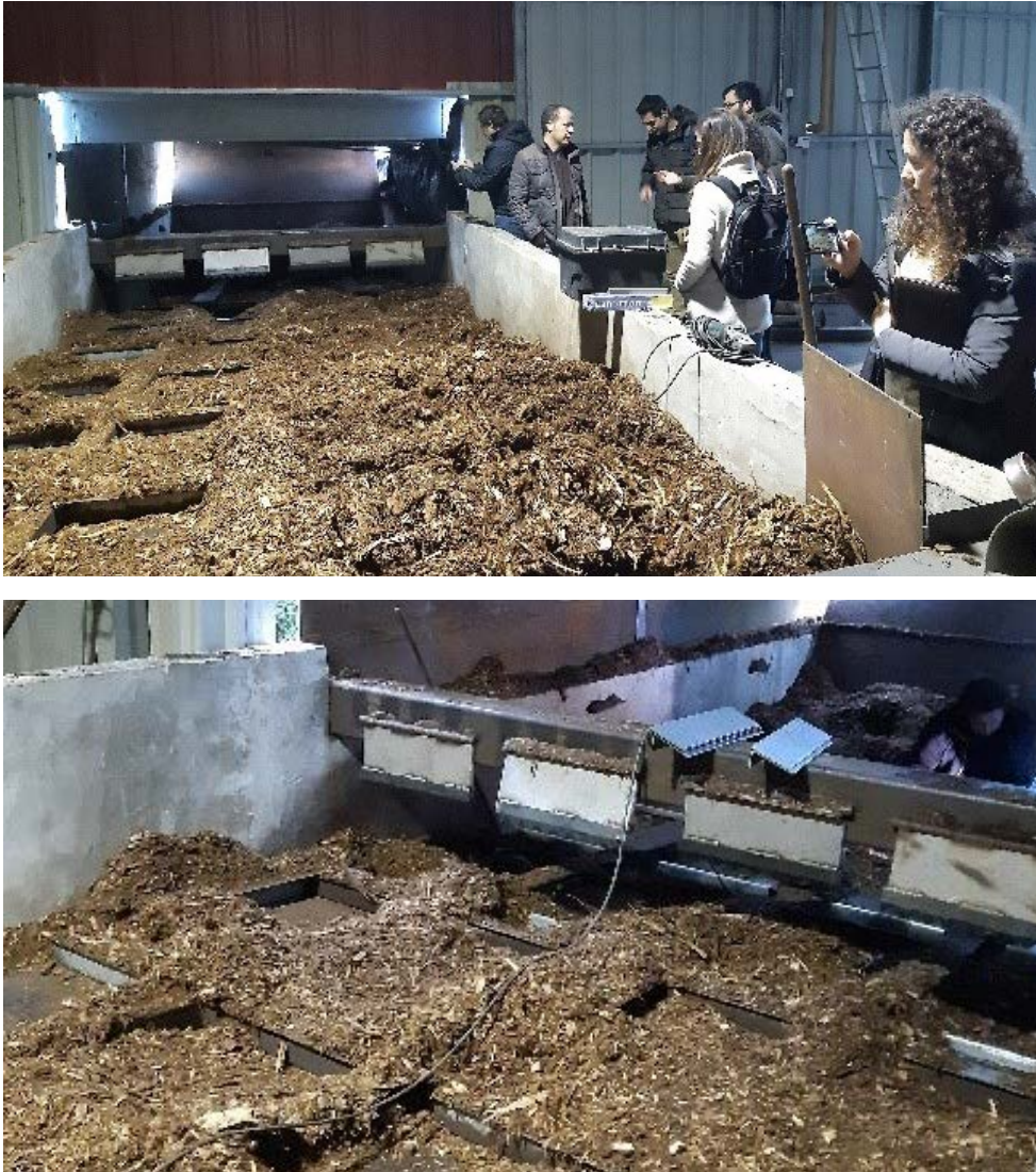
Figura 4. Sistema de alimentação das caldeiras.
